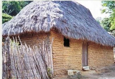
**Бахареке** – хижина индейцев Гватемалы. Стены – из жердей и веток, обмазанных глиной. Крыша – из сухой травы или соломы, пол – из утрамбованного грунта. Бахареке устойчивы к сильным землетрясениям, случающимся в Центральной Америке.
