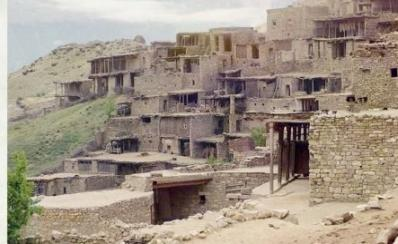
**Сакля** – дом жителей горных местностей Кавказа и Крыма. Обычно это дом из камня, глины или сырого кирпича с плоской крышей и узкими окнами, похожими на бойницы. Если сакля располагалась друг под другом на склоне горы, крыша нижнего дома запросто могла служить двором для верхнего. Балки каркаса делали выступающими, чтобы обстроить утепленные настилы. Впрочем, сакля здесь может называться и любая маленькая хижина с соломенной крышей.
