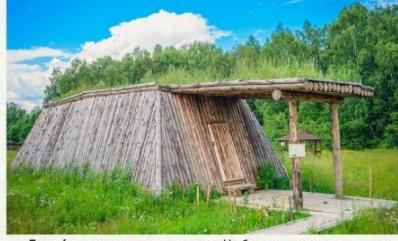
**Балаган** – зимнее жилище якутов. На бревенчатом каркасе укреплялись наклонные стены из тонких жердей, обмазанных глиной. Низкая пологая крыша покрывалась корой и землей. В маленькие окна вставлялись куски льда. Вход ориентирован на восток и прикрыт навесом. С западной стороны к балагану пристраивали хлев для скота.
