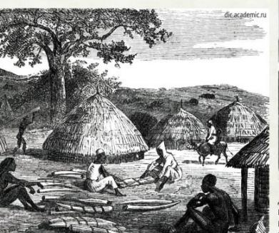
**Токуль** – круглая соломенная хижина жителей Судана (Восточная Африка). Несущие части стен и конической крыши делают из длинных стволов мимозы. Затем на них надевают обручи из гибких ветвей и покрывают соломой.
